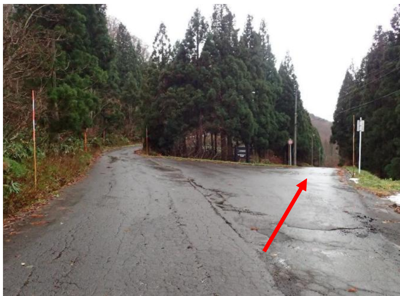
約2.4km先、右方向（上ノ岱地熱発電所方面）へ
